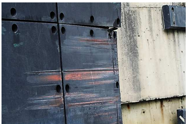
95.att. Kuģu atvairierīču aizsargpārklājuma bojājumi, korozija ūdens līmeņa mainīgajā zonā.
