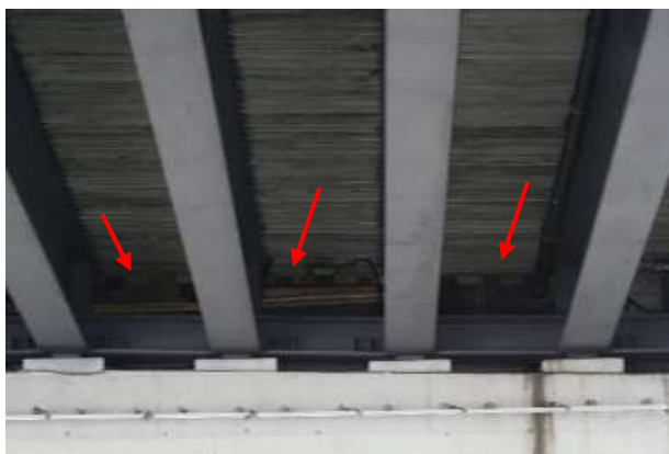
53.att. Laiduma konstrukcijas paliekošo veidņu bojājumi, to nekvalitatīvs remonts. Atstātie veidņu fragmenti.
