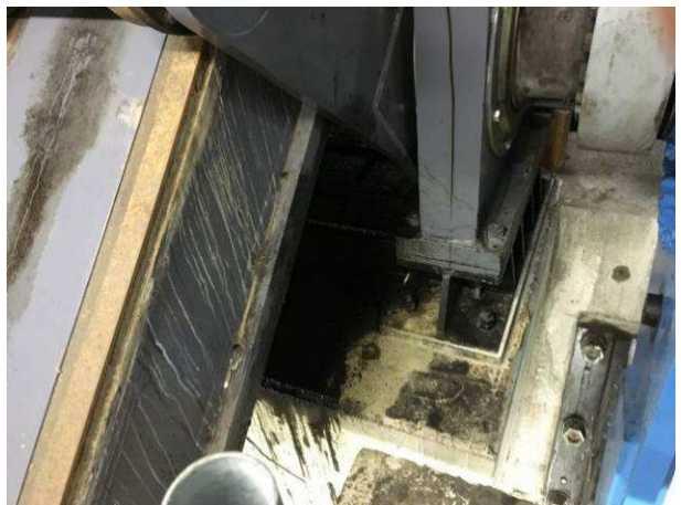
116.att. Zobrati, balsts Nr. 5. Betona konstrukcija ir noziesta ar eļļām.
