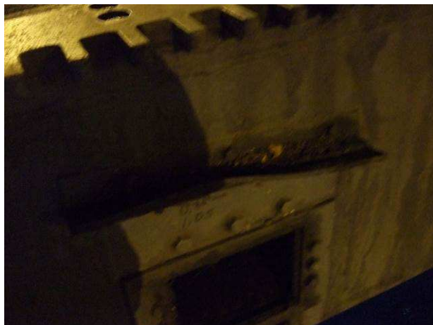
129.att. Paceļamā laiduma aizslēgmehānismam izliekta gumijas aizsargplāksne.
