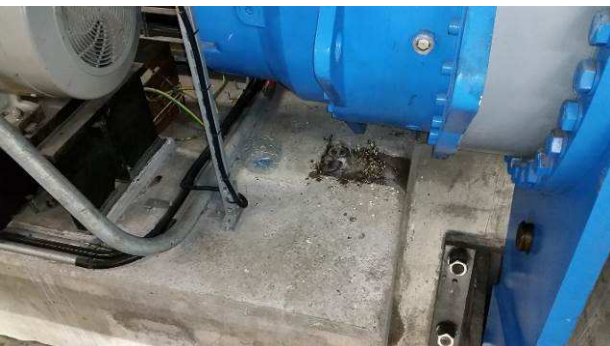
115.att. Planetārās pāresumkārbas balstā Nr. 5 (pirmās divas bildes) un balstā Nr. 6. defekti: aizsargpārklājuma bojājumi, kondensāta krāšanās, stiprinājumu korozija un putnu ligzda zem mehānisma.
