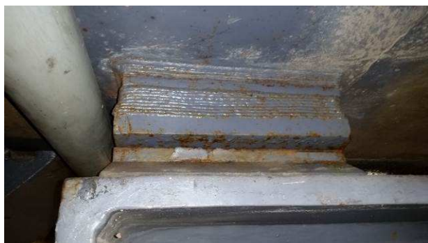
122.att. Balstīklām ir bojāts aizsargpārklājums, t.i. atslāņojas krāsa, ir pāris mehāniski bojājumi, kuru rezultātā veidojas korozija.
