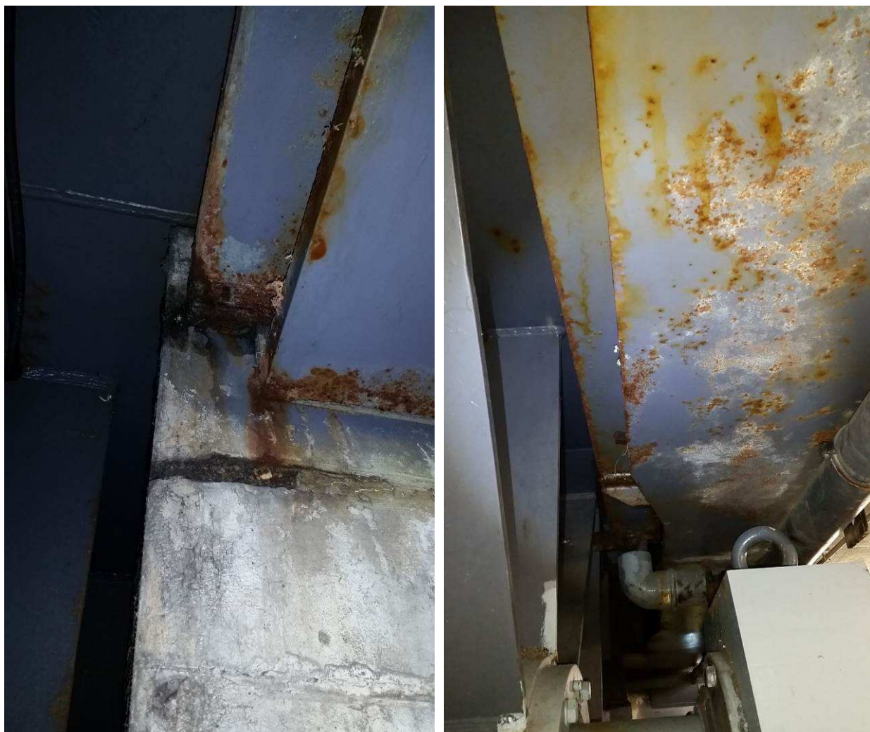
64.att. Tērauda elementu korozija, aizsargpārklājuma bojājumi. Rūsas notecējumi.
