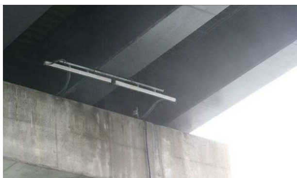
36.att. Ūdens notecējumi uz balsta Nr. 8 uzkala.
