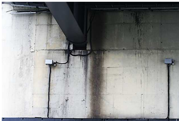
19.att. Betona virsmas pārklāta ar eļļu. Eļļas notecējumi uz balsta Nr. 5.
