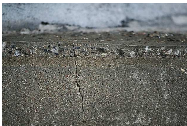
37.att. Plaisas un kavernas balsta Nr. 8 režģogā. Betona erozija mainīga ūdens līmeņa zonā.
