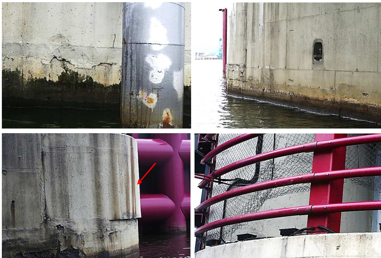
29.att. Betona erozija mainīgā ūdens līmeņa zonā. Rūsas notecējumi. Dīķera aizsargpārklājuma bojājumi. Balsta Nr. 6 nožogojuma bojājumi.
