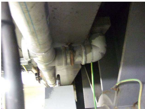
126.att. Ūdens atvades caurulēm novērojama ūdens noplūde, saplīsušas caurules un stiprinājumu korozija.
