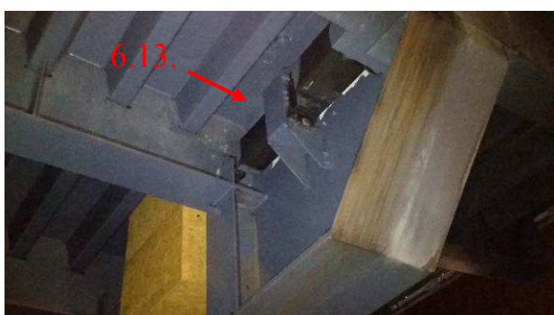
108.att. Pretsvara stabilizators (pretsvara piekāršanas ass mezgls). Savilces ar atbalstpunktiem (paralēlais stienis).
