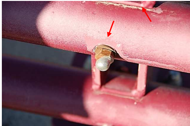
86.att. Aizsargpārklājuma bojājumi, sārmais aplikums, stiprinājumu korozija.
