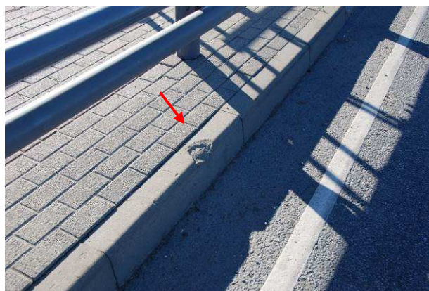
83.att. Pretslīdes pārklājuma nodilums, atslāņošanās laidumā Nr. 5-6.
