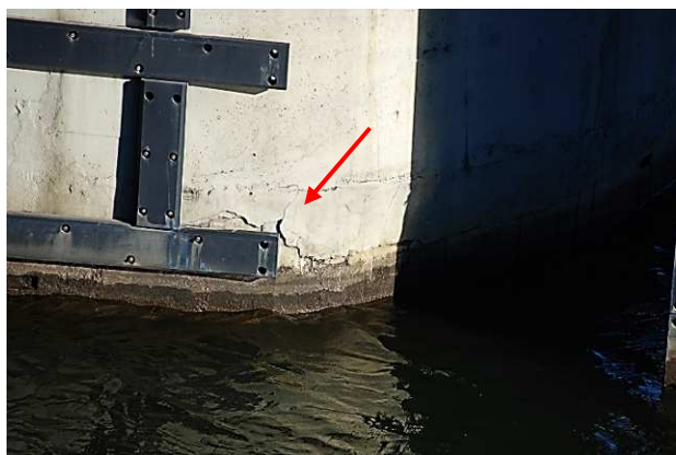
22.att. Betona bojājumi mainīgā ūdens līmeņa zonā. Dīķera aizsargpārklājuma bojājumi.
