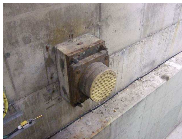
122.att. Balstīklām ir bojāts aizsargpārklājums, t.i. atslāņojas krāsa, ir pāris mehāniski bojājumi, kuru rezultātā veidojas korozija.
