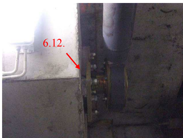
108.att. Pretsvara stabilizators (pretsvara piekāršanas ass mezgls). Savilces ar atbalstpunktiem (paralēlais stienis).
