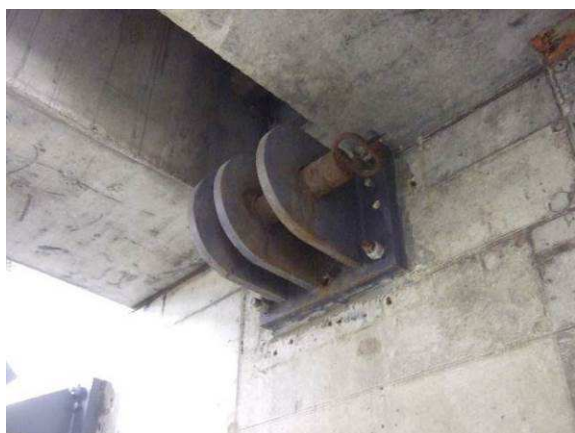
124.att. Bloķējošā ierīce. Defekti: vārpstas un stiprinājumu korozija.
