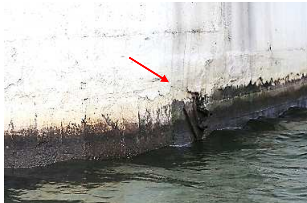
17.att. Plaisu tīkls balsta Nr. 4 režģogā. Betona apaugšana ar veģitāciju un aizsargkārtas bojājums mainīgā ūdens līmeņa zonā.
