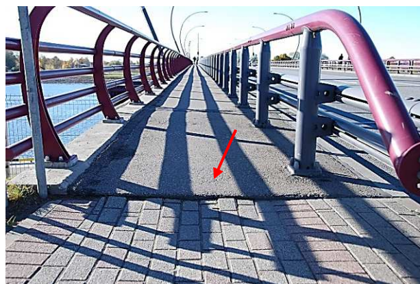
45.att. Konusa stiprinājuma grunts izskalojums.
