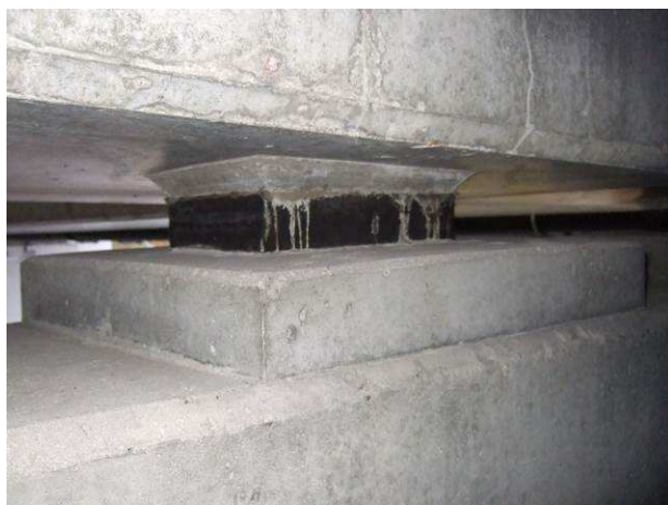
72.att. Dzelzsbetona un tērauda laidumu balsta Nr. 9 balstīklas.
