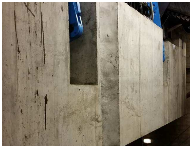
127.att. Betona atsvaru apakšpusēs novērojami izsvīdumi.
