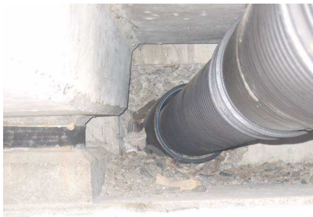
5.att. Balsta Nr. 1 izdrupināta betona siena.
