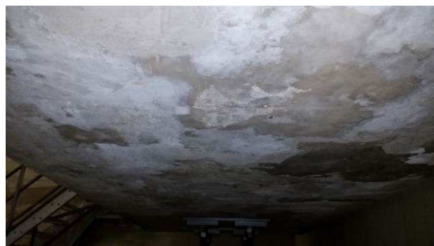
126.att. Ūdens atvades caurulēm novērojama ūdens noplūde, saplīsušas caurules un stiprinājumu korozija.
