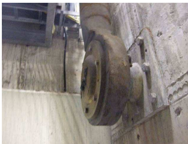
121.att. Savilces ar atbalstpunktiem (paralēlais stienis). Defekti: stienļa un stiprinājuma plāksnes aizsargslāņa bojājumi. Vietās, kur savilce piestiprinās pie betona balsta konstrukcijas, izdrupis izlīdzinošais javas slānis.
