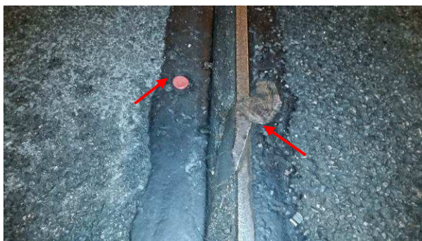
76.att. Hermētiskas šuves nekvalitatīva iestrādāšana virs balsta Nr. 6.
