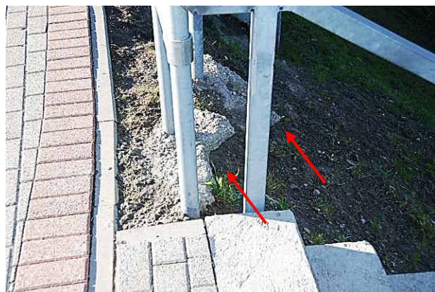
45.att. Konusa stiprinājuma grunts izskalojums.
