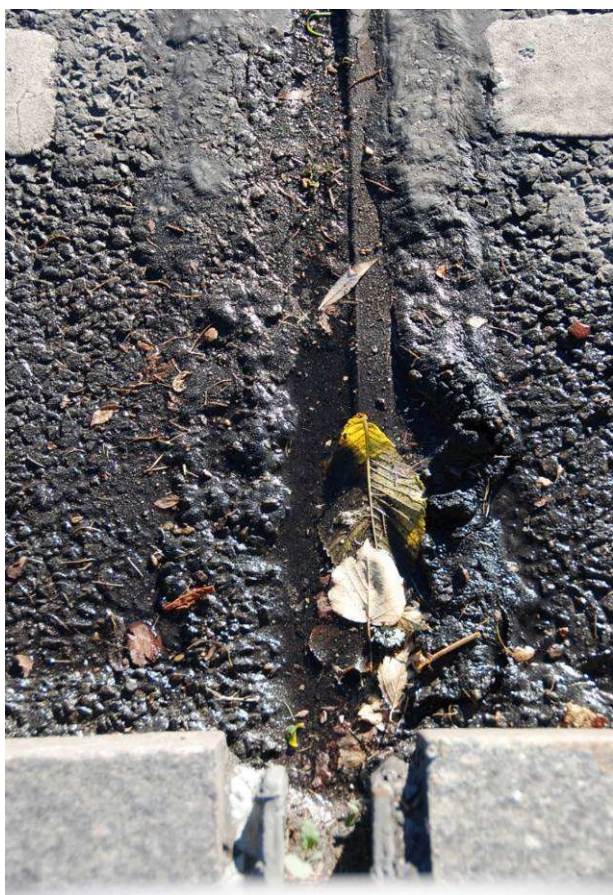
75.att. Deformācijas šuves virs balsta Nr. 6 elementu korozija, aizsērējumi. Bitumena mastikas hermētiķa defekti.
