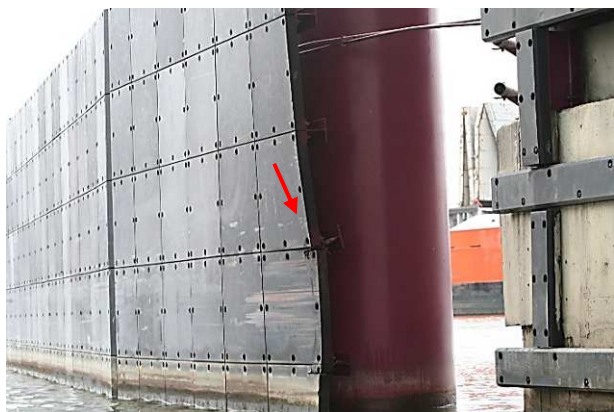
95.att. Kuģu atvairierīču aizsargpārklājuma bojājumi, korozija ūdens līmeņa mainīgajā zonā.
