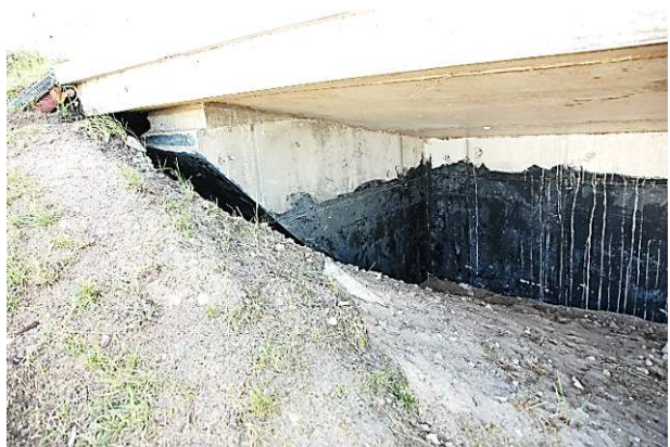
42.att. Grunts izskalojums pie balsta Nr. 1.
