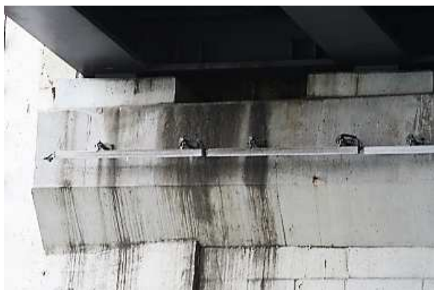
19.att. Betona virsmas pārklāta ar eļļu. Eļļas notecējumi uz balsta Nr. 5.
