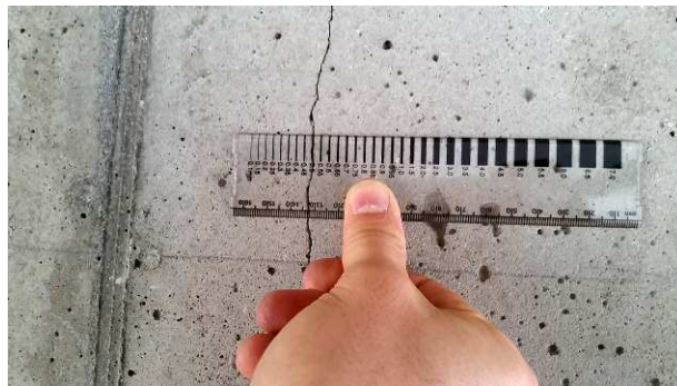
47.att. Aizsargkārtas bojājums (no veidņiem neizskalota sienamā stieple) un plaisas sijā Nr. 5.
