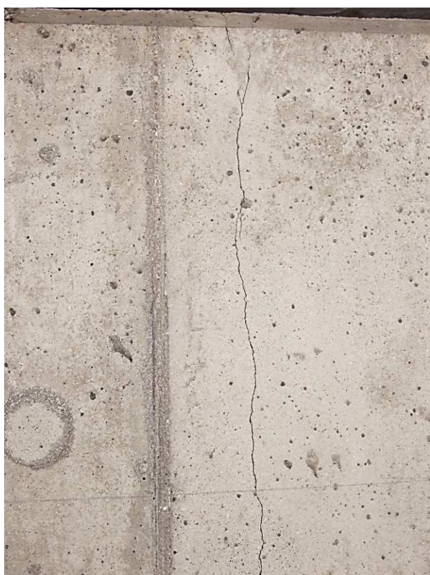
10.att. Plaisas balsta Nr. 2 uzkalā un režģogā. Rūsas notecējumi uz balsta Nr. 2 ietves zonā.
