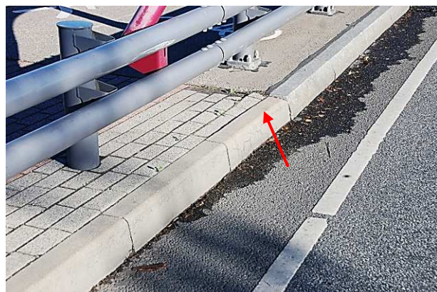
46.att. Seguma sēšanās ietvju zonā balstu pieejās. Bojājumi tilta betona apmalē virs krasta balsta Nr. 1.
