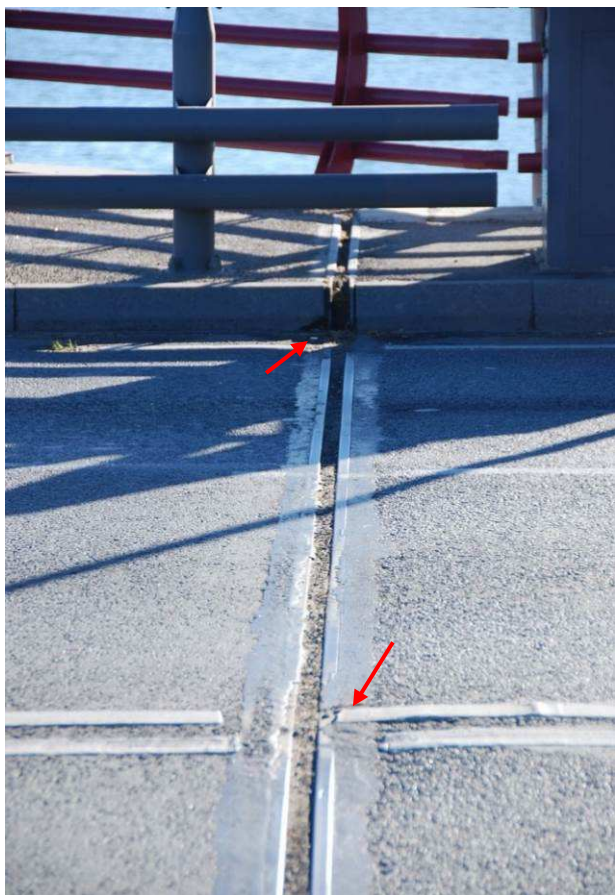
75.att. Deformācijas šuves virs balsta Nr. 6 elementu korozija, aizsērējumi. Bitumena mastikas hermētiķa defekti.
