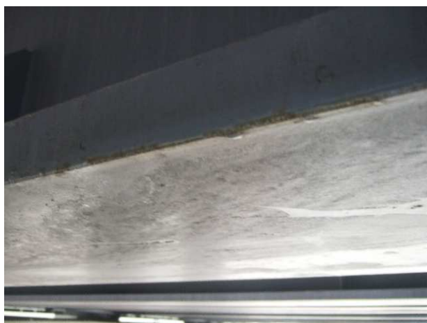
60.att. Tērauda sijas Nr. 8 aizsargpārklājuma bojājumi, siju krāsojuma biezuma mērījumi.
