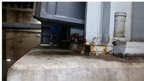
119.att. Galvenie rotācijas punkti (laiduma rotācijas ass mezgli). Defekti: virsmas pārklājuma bojājumi, t.i. krāsas atslāņošanās, izteikta elementu korozija; metinājuma šuvju korozija, gultņu korpusu nobrāzumi.
