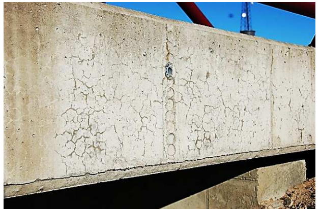
4.att. Balsta Nr.1 sienas betona virsmas bojājumi. Plaisu tīkls balsta Nr. 1 ietvyu malas sijām.
