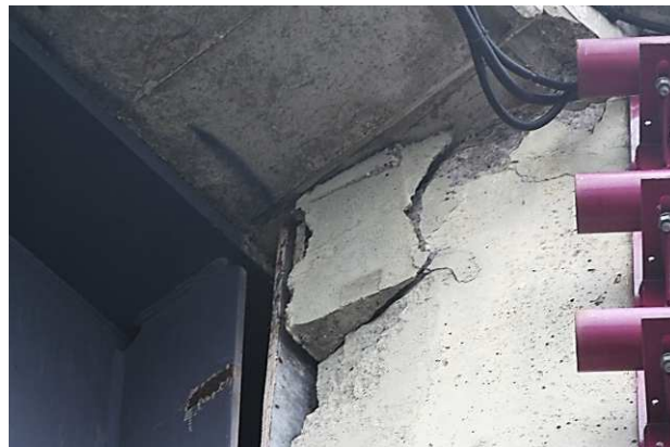
27.att. Balstam Nr. 6 no laiduma Nr. 6-7 puses atlūzuši betona gabali augštes un lejtes pusēs.
