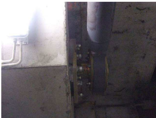
121.att. Savilces ar atbalstpunktiem (paralēlais stienis). Defekti: stienļa un stiprinājuma plāksnes aizsargslāņa bojājumi. Vietās, kur savilce piestiprinās pie betona balsta konstrukcijas, izdrupis izlīdzinošais javas slānis.
