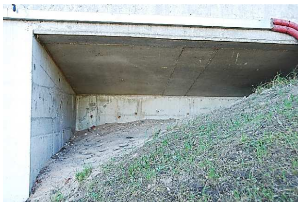
44.att. Grunts izskalojums pie balsta Nr. 10.
