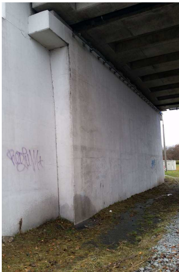
89.att. Neatbilstība drenāžas cauruļu pieslēgumā kopējai pilsētas lietās ūdens savākšanas sistēmai. Šī defekta dēļ, ūdens tek uz balstu, bojājot to, kā arī dzelzceļa uzbērumu, kas nākotnē var radīt nopietnus defektus tās klātnes konstrukcijā.
