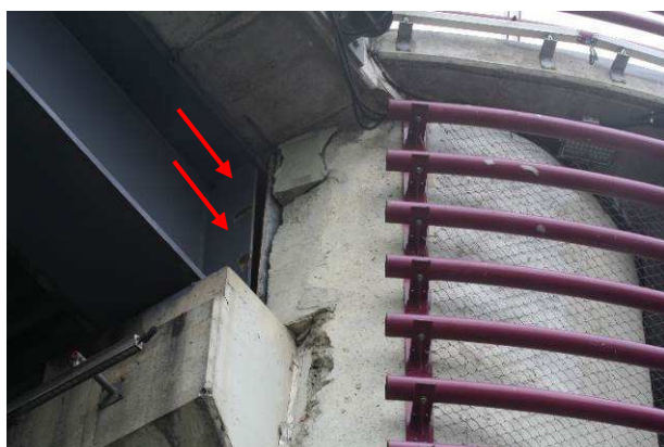
66.att. Tērauda sijas aizsargpārklājuma bojājumi.
