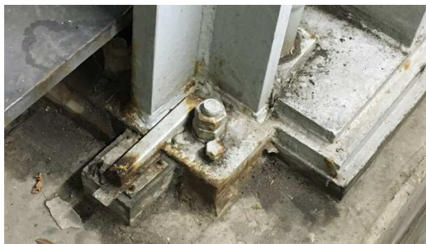
119.att. Galvenie rotācijas punkti (laiduma rotācijas ass mezgli). Defekti: virsmas pārklājuma bojājumi, t.i. krāsas atslāņošanās, izteikta elementu korozija; metinājuma šuvju korozija, gultņu korpusu nobrāzumi.
