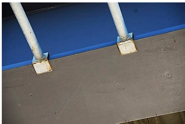
97.att. Brīdinājuma zīmju stiprinājumu korozija.
