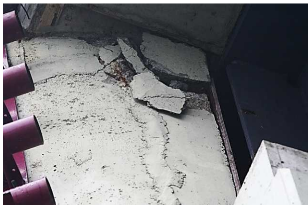
27.att. Balstam Nr. 6 no laiduma Nr. 6-7 puses atlūzuši betona gabali augštes un lejtes pusēs.
