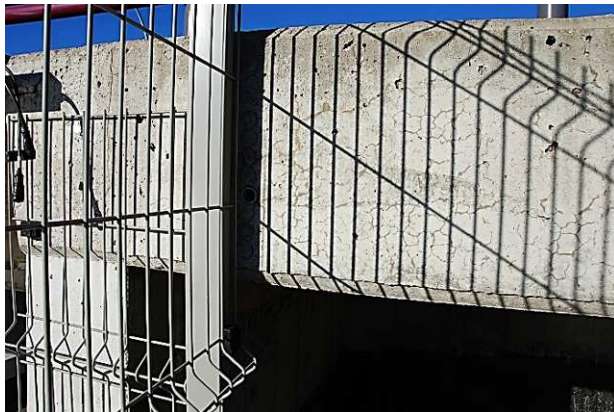
4.att. Balsta Nr.1 sienas betona virsmas bojājumi. Plaisu tīkls balsta Nr. 1 ietvyu malas sijām.
