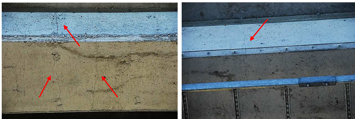
58.att. Plaisas betona sijās Nr. 7 un 8.
