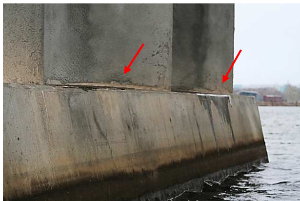
13.att. Torkretētās kārtas bojājumi. Plaisas balsta Nr. 3 režģogā un uzkalā
