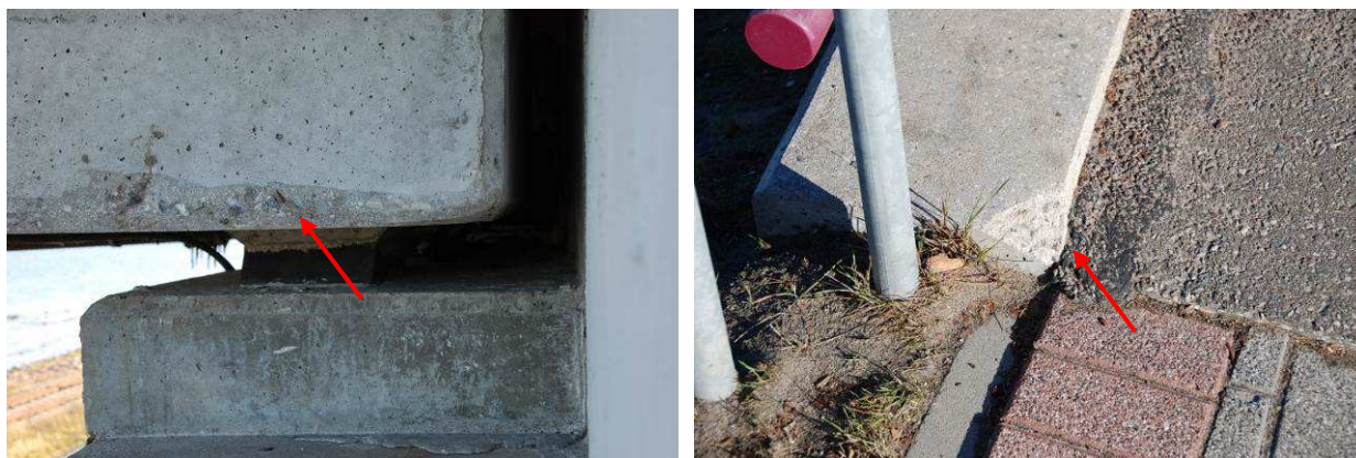
59.att. Betona atšķelšanās sijai Nr.8, aizsargkārtas bojājums.
