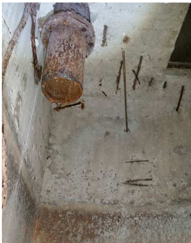
23.att. Betona balsta Nr. 5 grīda (zem atsvara blokiem) un vecas dienesta telpas drenāžas sistēma un griesti.
