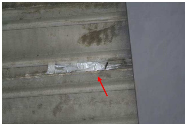
53.att. Laiduma konstrukcijas paliekošo veidņu bojājumi, to nekvalitatīvs remonts. Atstātie veidņu fragmenti.
