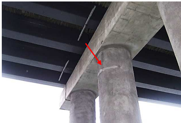
34.att. Plaisas un kavernas balsta Nr. 7 režģogā. Torkretētās betona kārtas atslāņošanās.
