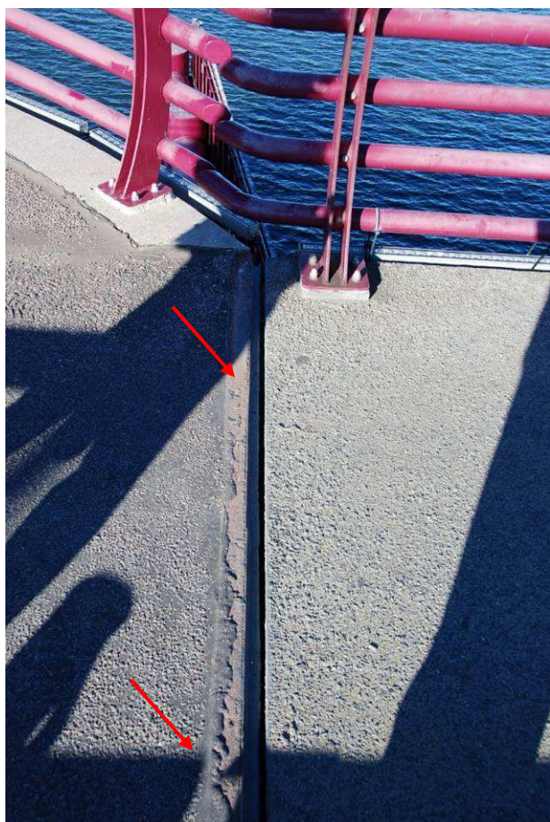
77.att. Paceļamā laiduma deformācijas šuve virs balsta Nr. 6.
