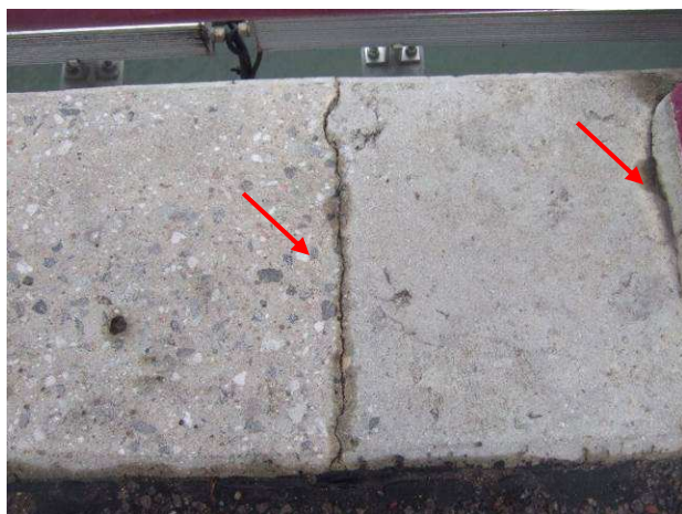
54.att. Plaisas laiduma konstrukcijas sānu sijā.
