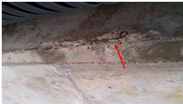
47.att. Aizsargkārtas bojājums (no veidņiem neizskalota sienamā stieple) un plaisas sijā Nr. 5.
