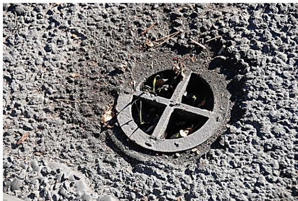
90.att. Ūdens atvades, no brauktuves, drenāžas sistēmas aizsērējums.
