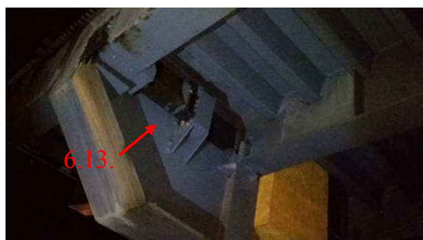
109.att. Aizslēgmehānisms (laiduma atslēga).
