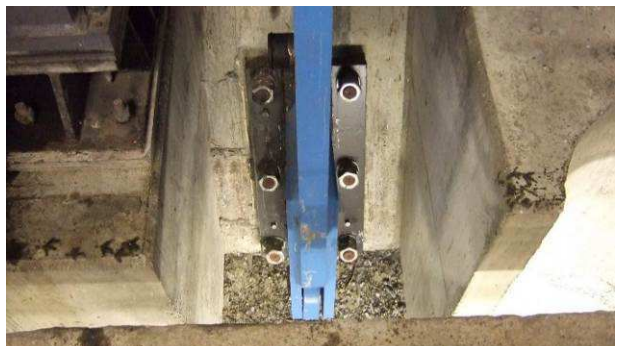
115.att. Planetārās pāresumkārbas balstā Nr. 5 (pirmās divas bildes) un balstā Nr. 6. defekti: aizsargpārklājuma bojājumi, kondensāta krāšanās, stiprinājumu korozija un putnu ligzda zem mehānisma.
