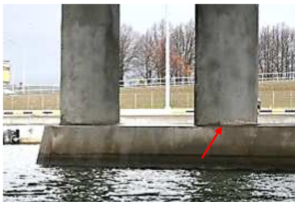
16.att. Torkretētās kārtas atslāņošanās (trūkums). Rūsas notecējumi uz balsta Nr. 4 uzkala.
