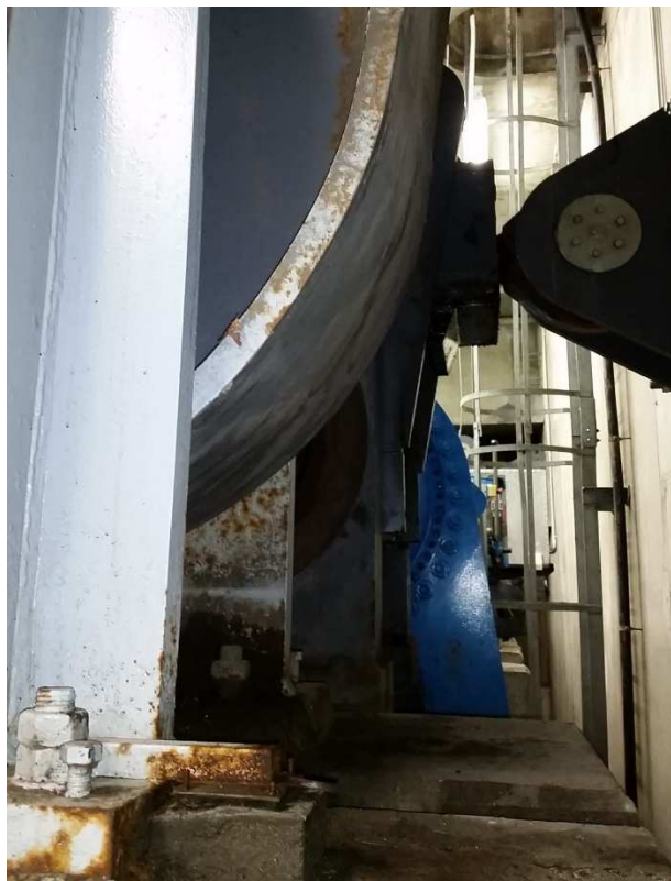
120.att. Pretsvara stabilizators (pretsvara piekāršanas ass mezgls). Defekti: tērauda elementu un stiprinājumu korozija, kā arī laiduma konstrukcijas sijas korozija.
