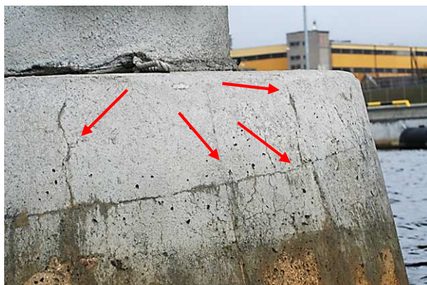
17.att. Plaisu tīkls balsta Nr. 4 režģogā. Betona apaugšana ar veģitāciju un aizsargkārtas bojājums mainīgā ūdens līmeņa zonā.
