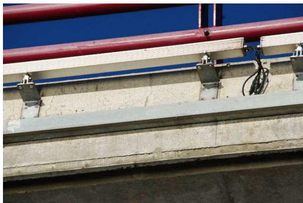
50.att. Plaisas laiduma konstrukcijas sānu sijās.
