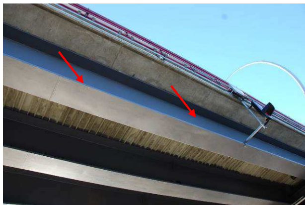
63.att. Tērauda siju aizsargpārklājuma bojājumi.
