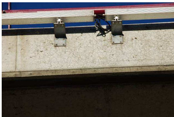
48.att. Plaisu tīkls laiduma konstrukcijā ietves sānu sijā.
