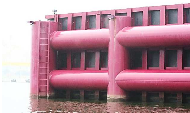
95.att. Kuģu atvairierīču aizsargpārklājuma bojājumi, korozija ūdens līmeņa mainīgajā zonā.
