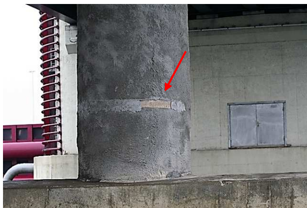
34.att. Plaisas un kavernas balsta Nr. 7 režģogā. Torkretētās betona kārtas atslāņošanās.
