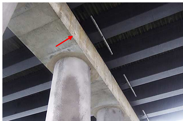
16.att. Torkretētās kārtas atslāņošanās (trūkums). Rūsas notecējumi uz balsta Nr. 4 uzkala.
