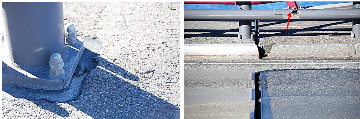
87.att. Hermētiskas šuves defekts. Barjera elementa bojājums virs 5. balsta, lejteces pusē.
