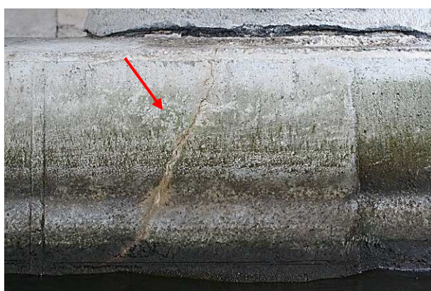
36.att. Ūdens notecējumi uz balsta Nr. 8 uzkala.
