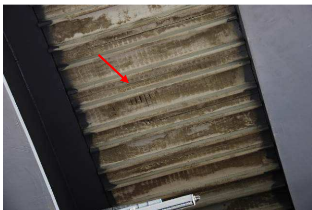
51.att. Laiduma konstrukcijas paliekošo veidņu betona aizsargkārtas bojājumi.
