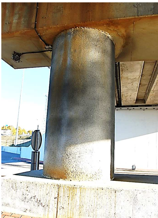
10.att. Plaisas balsta Nr. 2 uzkalā un režģogā. Rūsas notecējumi uz balsta Nr. 2 ietves zonā.
