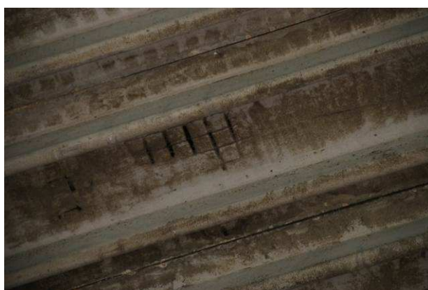
51.att. Laiduma konstrukcijas paliekošo veidņu betona aizsargkārtas bojājumi.
