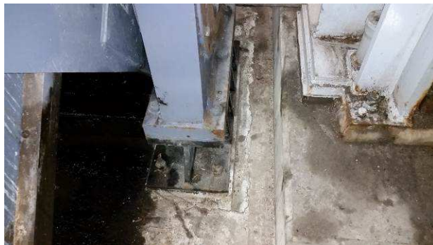
119.att. Galvenie rotācijas punkti (laiduma rotācijas ass mezgli). Defekti: virsmas pārklājuma bojājumi, t.i. krāsas atslāņošanās, izteikta elementu korozija; metinājuma šuvju korozija, gultņu korpusu nobrāzumi.
