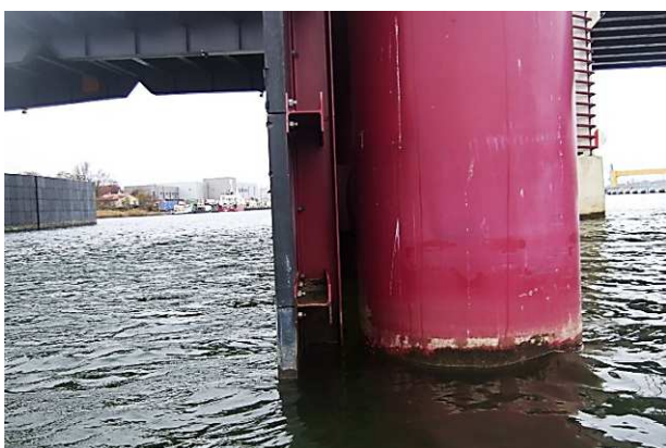
92.att. Kuģu atvairierīču aizsargpārklājuma bojājumi, tērauda konstrukciju korozija ūdens līmeņa mainīgajā zonā.
