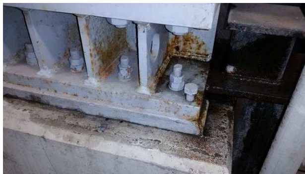
119.att. Galvenie rotācijas punkti (laiduma rotācijas ass mezgli). Defekti: virsmas pārklājuma bojājumi, t.i. krāsas atslāņošanās, izteikta elementu korozija; metinājuma šuvju korozija, gultņu korpusu nobrāzumi.
