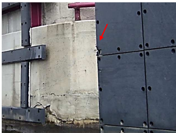
93.att. Kuģu atvairierīču nosedzošo paneļu bojājumi.
