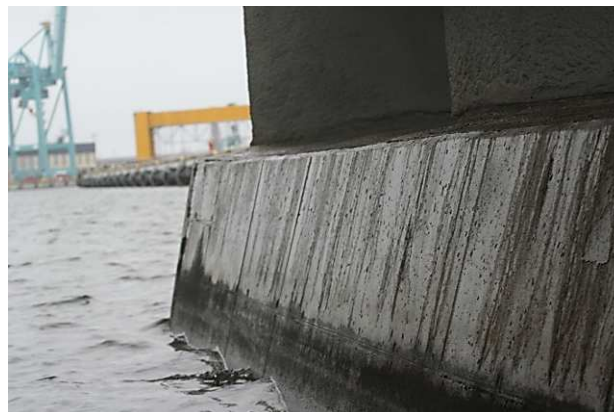
13.att. Torkretētās kārtas bojājumi. Plaisas balsta Nr. 3 režģogā un uzkalā
