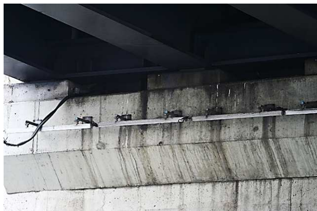
26.att. Betona virsmas pārklātas ar eļļu. Notecējumi uz balsta Nr. 6.
