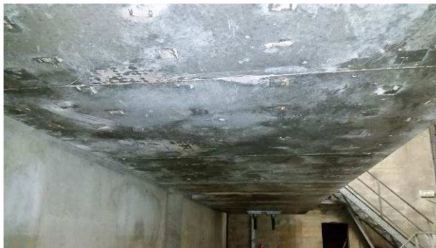
126.att. Ūdens atvades caurulēm novērojama ūdens noplūde, saplīsušas caurules un stiprinājumu korozija.
