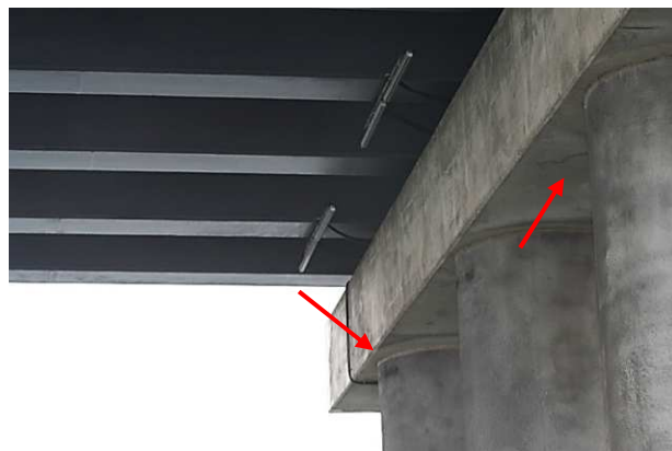
13.att. Torkretētās kārtas bojājumi. Plaisas balsta Nr. 3 režģogā un uzkalā
