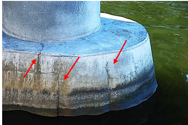
14.att. Betona apaugšana ar veģitāciju mainīgā ūdens līmeņa zonā. Plaisas balsta Nr. 3 režģogā un uzkalā.
