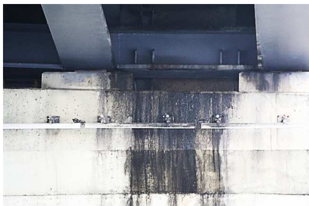
26.att. Betona virsmas pārklātas ar eļļu. Notecējumi uz balsta Nr. 6.
