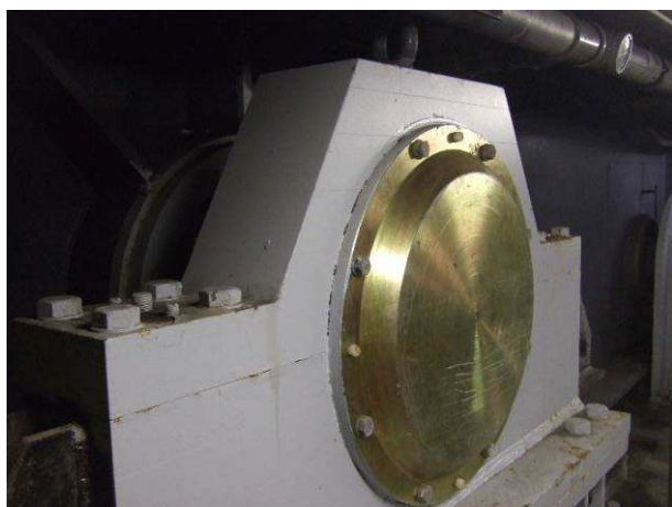
107.att. Galvenie rotācijas punkti (laiduma rotācijas ass mezgls).
