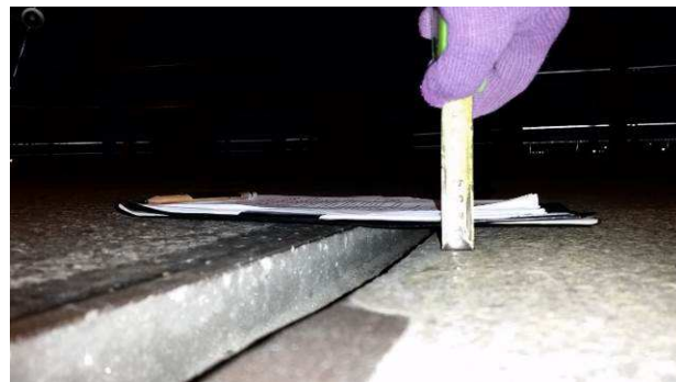
78.att. Paceļamā laiduma Nr. 5-6 nelīdzenums pie tērauda laiduma Nr. 6-7.
