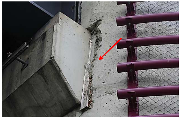
27.att. Balstam Nr. 6 no laiduma Nr. 6-7 puses atlūzuši betona gabali augštes un lejtes pusēs.
