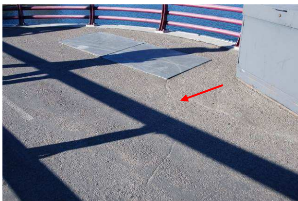
81.att. Ietves virskārtas pretslīdes pārklājuma nodilums.
