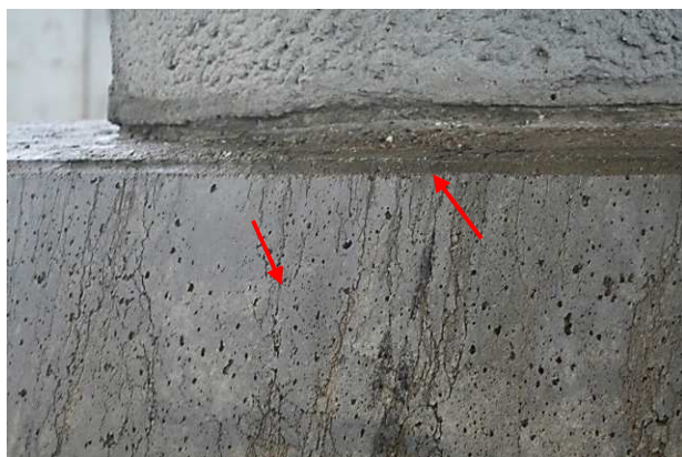
13.att. Torkretētās kārtas bojājumi. Plaisas balsta Nr. 3 režģogā un uzkalā
