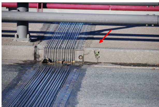
84.att. Betona apmales akmeņu bojājumi.
