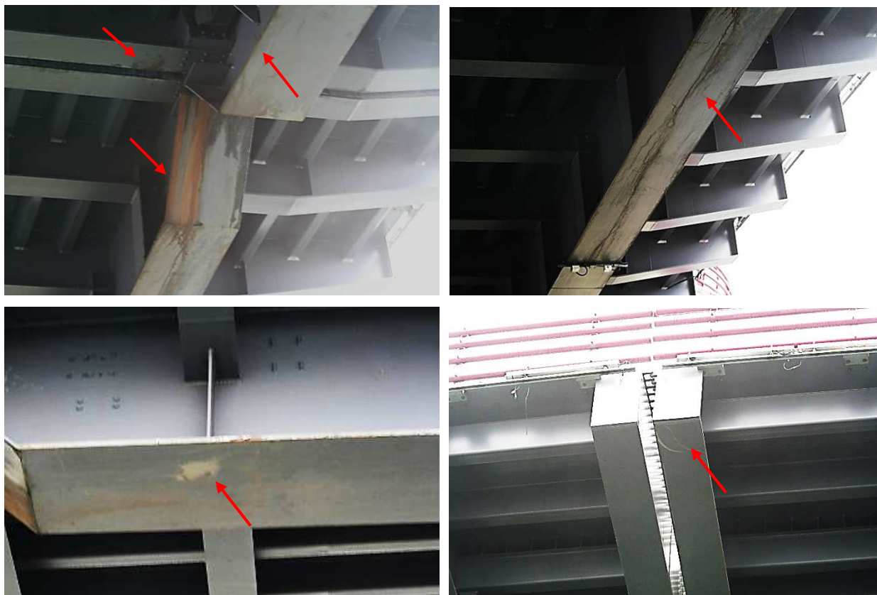
64.att. Tērauda elementu korozija, aizsargpārklājuma bojājumi. Rūsas notecējumi.
