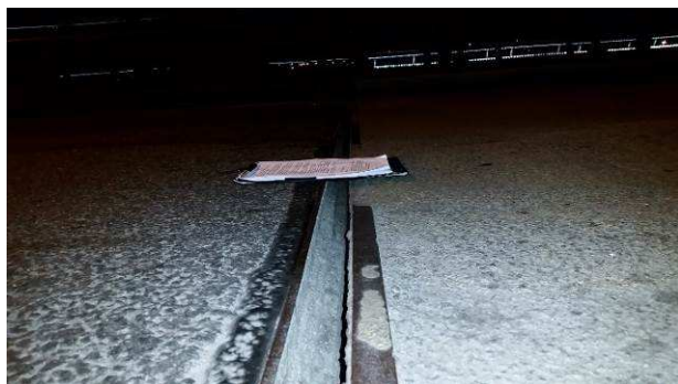
78.att. Paceļamā laiduma Nr. 5-6 nelīdzenums pie tērauda laiduma Nr. 6-7.
