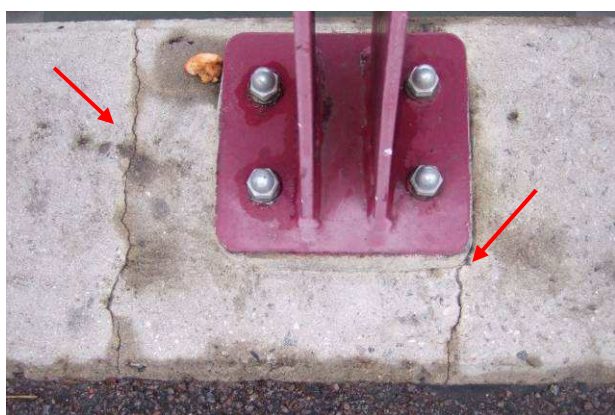
52.att. Plaisas laiduma konstrukcijas sānu sijā, ietves pusē. Atstātie veidņu fragmenti.
