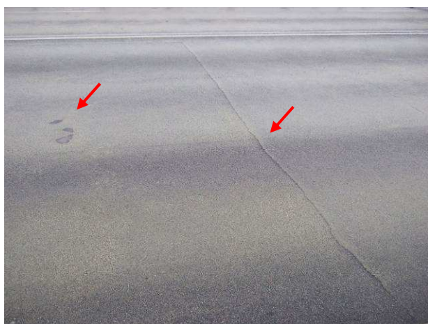
83.att. Pretslīdes pārklājuma nodilums, atslāņošanās laidumā Nr. 5-6.
