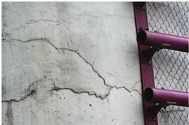
27.att. Balstam Nr. 6 no laiduma Nr. 6-7 puses atlūzuši betona gabali augštes un lejtes pusēs.
