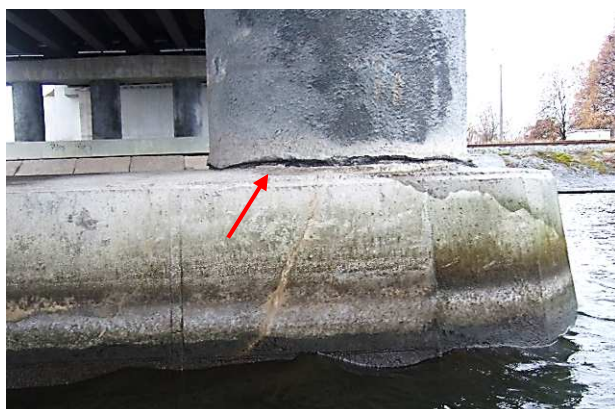
14.att. Betona apaugšana ar veģitāciju mainīgā ūdens līmeņa zonā. Plaisas balsta Nr. 3 režģogā un uzkalā.
