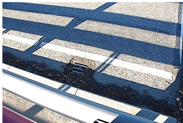
90.att. Ūdens atvades, no brauktuves, drenāžas sistēmas aizsērējums.
