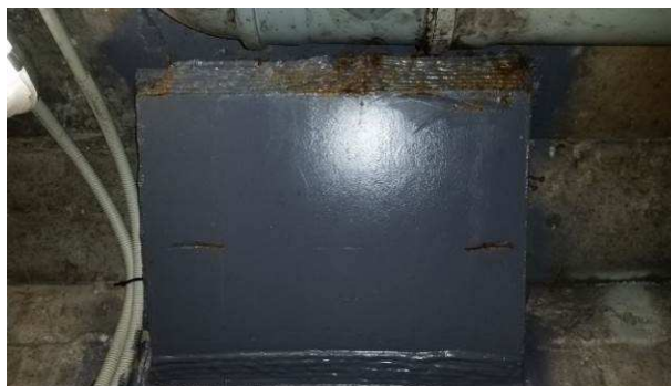
122.att. Balstīklām ir bojāts aizsargpārklājums, t.i. atslāņojas krāsa, ir pāris mehāniski bojājumi, kuru rezultātā veidojas korozija.
