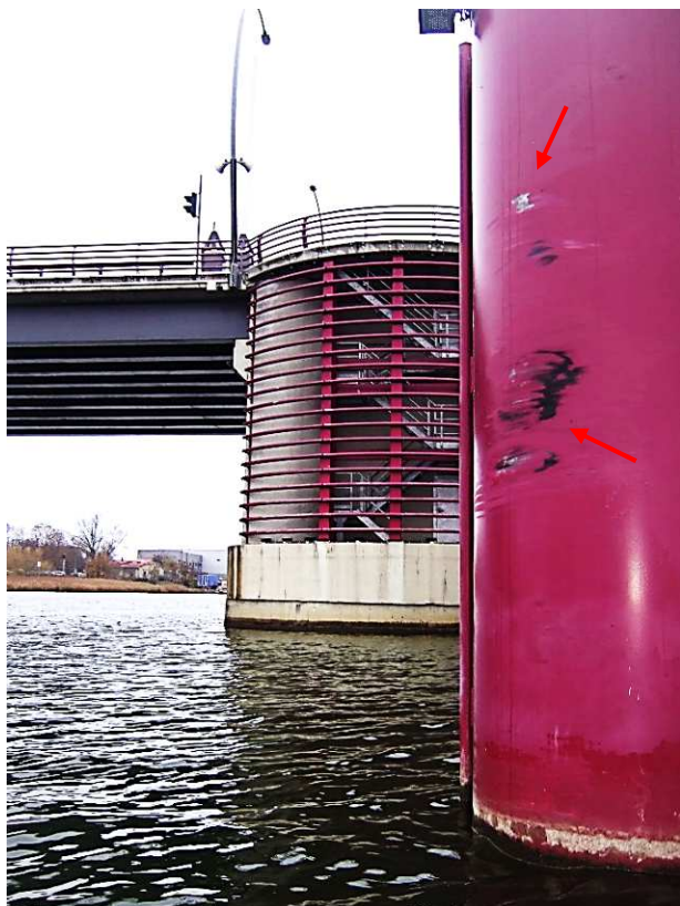
96.att. Kuģu atvairierīču paneļu un tērauda konstrukciju bojājumi (iespējams kuģa trieciena rezultātā).
