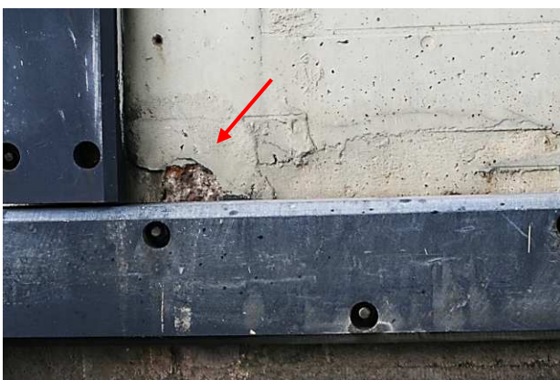
22.att. Betona bojājumi mainīgā ūdens līmeņa zonā. Dīķera aizsargpārklājuma bojājumi.
